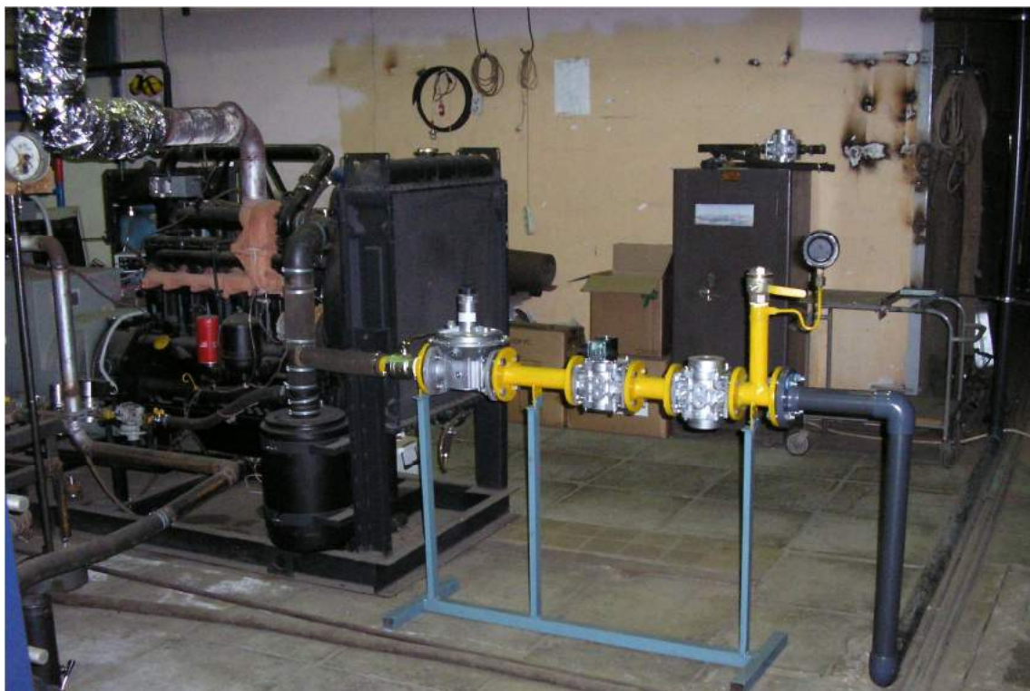
Рисунок 4.2 – Испытания ГПУ на синтез-газе
