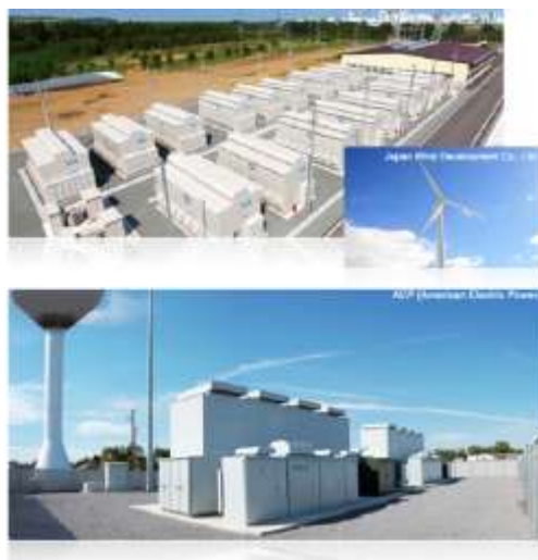
Рис.15. Примеры применения натрий-серных аккумуляторов для регулирования работы ветроэлектростанции мощностью 51 МВт (вверху, мощность накопителя 34 МВт) и подстанции централизованной электросети в США (внизу). Фото представлено на сайте компании NGK Insulators LTD (Япония).
