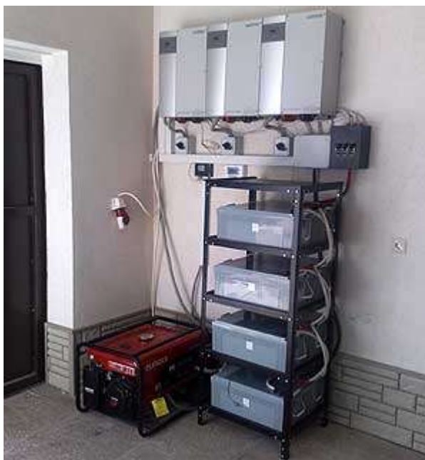
Рис.8. Гелевые 12-В аккумуляторные батареи в составе домашней энергосистемы [12].
