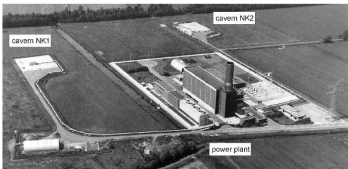
Рис.5. Станция Huntorf (Саар, ФРГ) эксплуатируется с 1978 года. Мощность в компрессорном режиме 60 МВт (до 12 ч), в генераторном – 290 МВт (до 3 ч). Рабочее давление – 70 атм.
