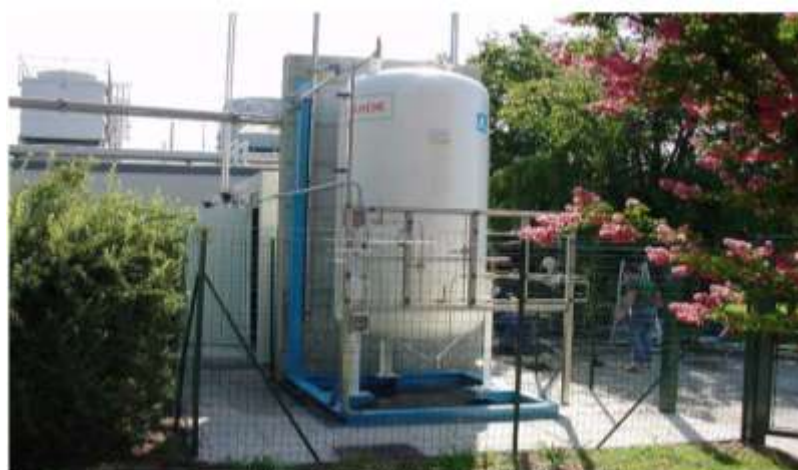
Рис.25. Хранилище водорода (4 м 3 , 10 бар) пилотной автономной солнечно-водородной энергоустановки (Agrate, Италия)
