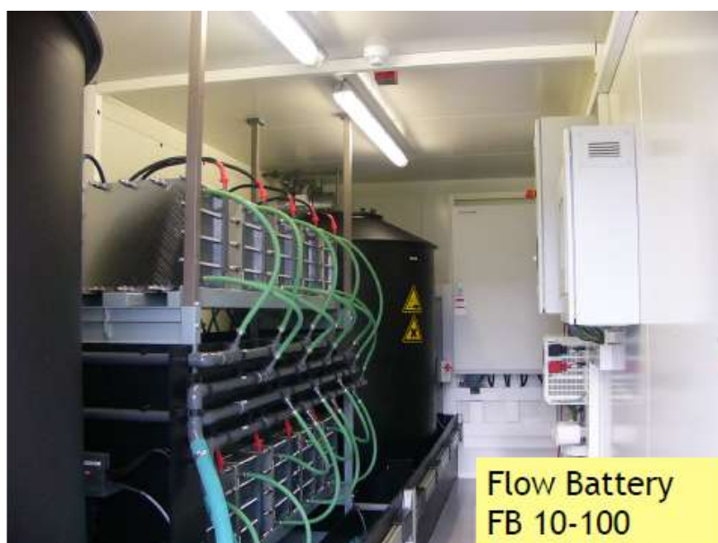
Рис. 33. Вид накопителя CellStrom Power FB-10-100 изнутри [40].
