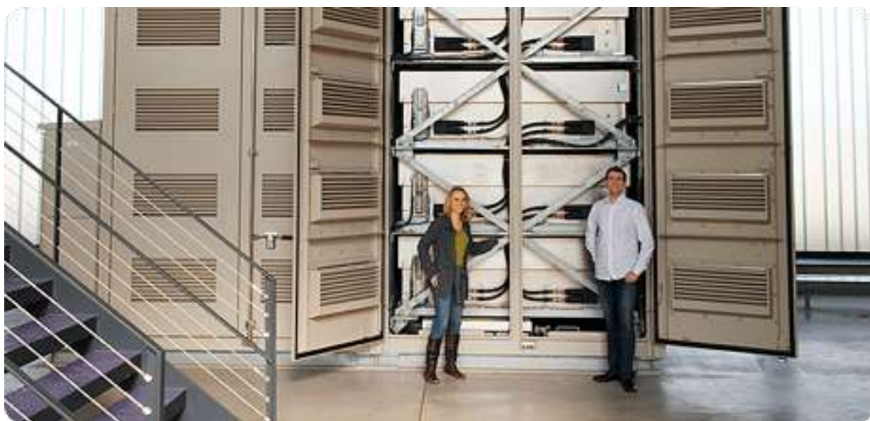
Рис. 17. Накопитель мощностью 200 кВт на площадке компании Younicos (ФРГ, Берлин)
