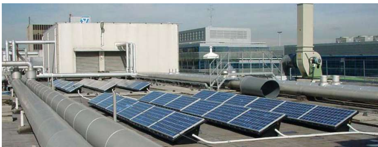
Рис. 221 Блок солнечных батарей (36 модулей PW1000) пилотной автономной солнечно-водородной энергоустановки (Agrate, Италия)
