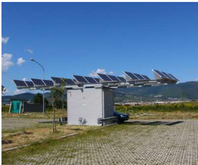
Рис.31. Опытный образец ванадиевого редокс-накопителя на автономной фотоэлектрической энергоустановке (Флоренция, Италия, мощность солнечной батареи – 3 кВт, мощность накопителя – 2 кВт, энергоемкость – 50 кВтч) [40].
