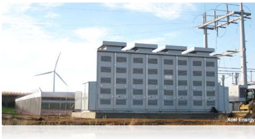
Рис.16. Натрий-серный аккумулятор в качестве буферного накопителя для ВЭУ (США)
