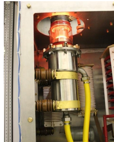
Рисунок 2.6. Генераторная лампа ГУ-23А.
