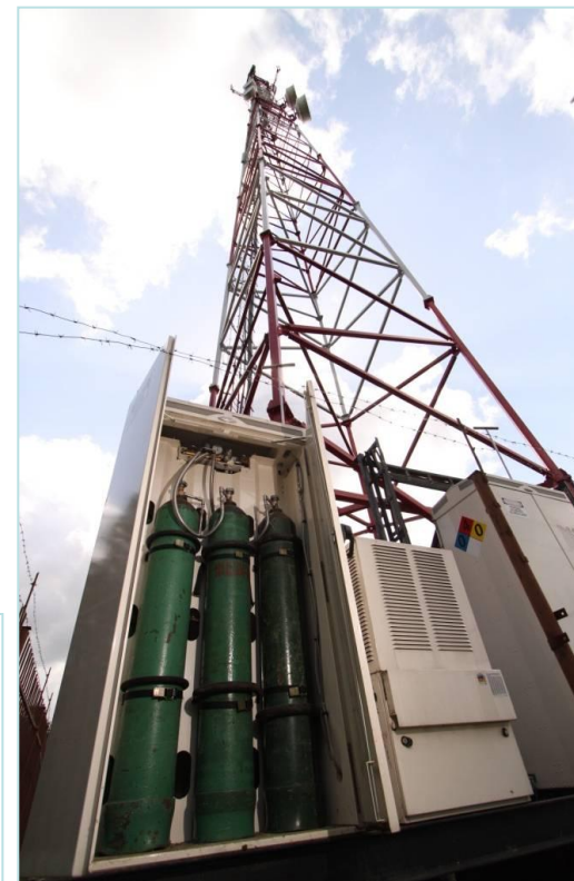
Система электропитания ретрансляционной станции сотовой связи
