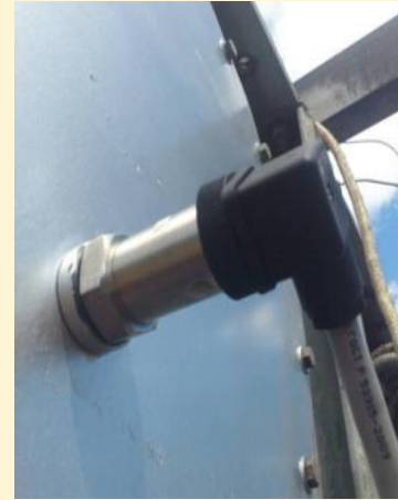
Датчик влажности и модуль сопряжения на подстанции «Каскара» ОАО «Тюменьэнерго»
