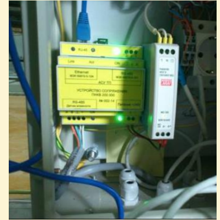
Датчик влажности и модуль сопряжения на подстанции «Каскара» ОАО «Тюменьэнерго»
