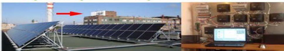
Пилотный проект автономной СЭС, 15 кВт, ФТИ им. А.Ф. Иоффе, 2012.
