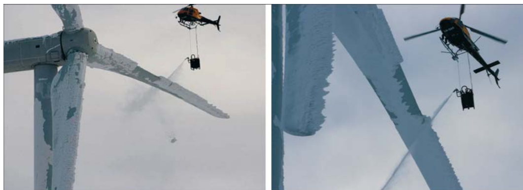
Рис. 3. Борьба с обледенением лопастей ВЭУ с помощью вертолёта.
